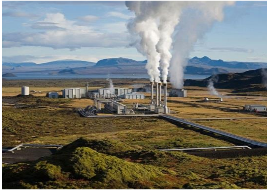
Obrázek 3 - Geotermální elektrárna Nesjavellir ležící v národním parku Þingvellir je největší svého druhu na Islandu, produkuje 120 MW elektrické energie a zároveň ohřívá 1800 litrů vody za minutu.
